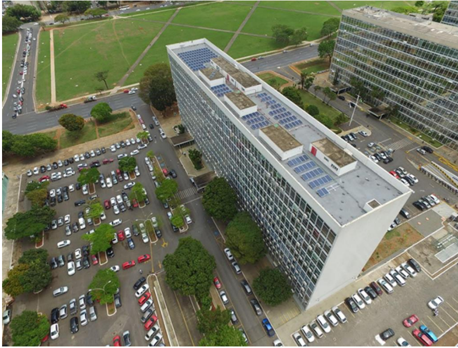
Figura 22 – Implantação de geração solar no topo do edifício do MME na Esplanada dos Ministérios
