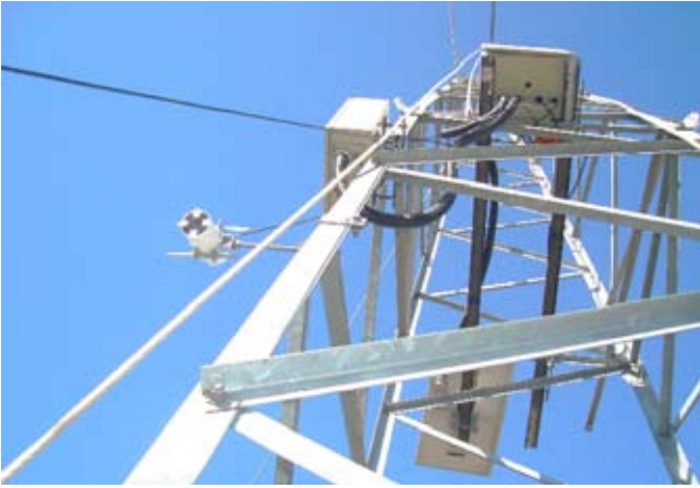
Figura 2. Detalhe da instalação do protótipo.
