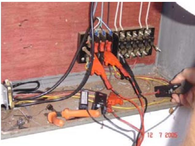
Figura 1. Técnico da concessionária realizando inspeção
