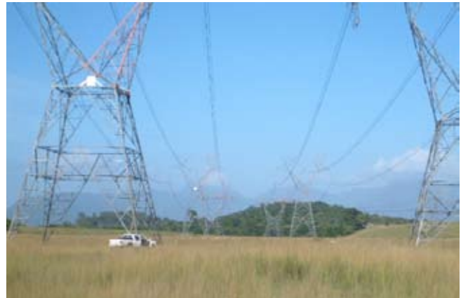
Figura 5. Vista das torres principal e repetidora após montagem
