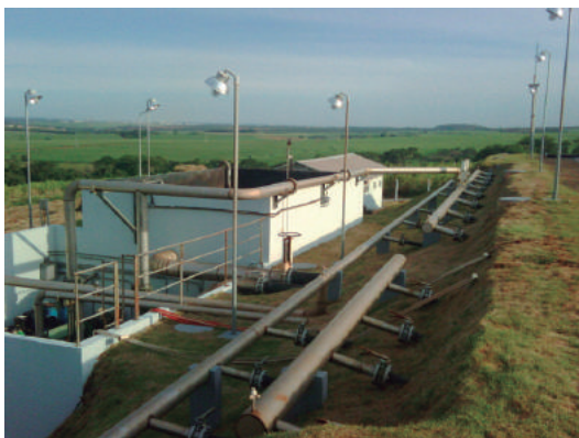
Figura 2. Tanque de mistura e sistemas de bombeamento e distribuição primários e secundários.
