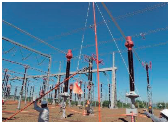
Figura 9. Instalação do grampo de aterramento na Subestação 440 kV Ilha Solteira.
