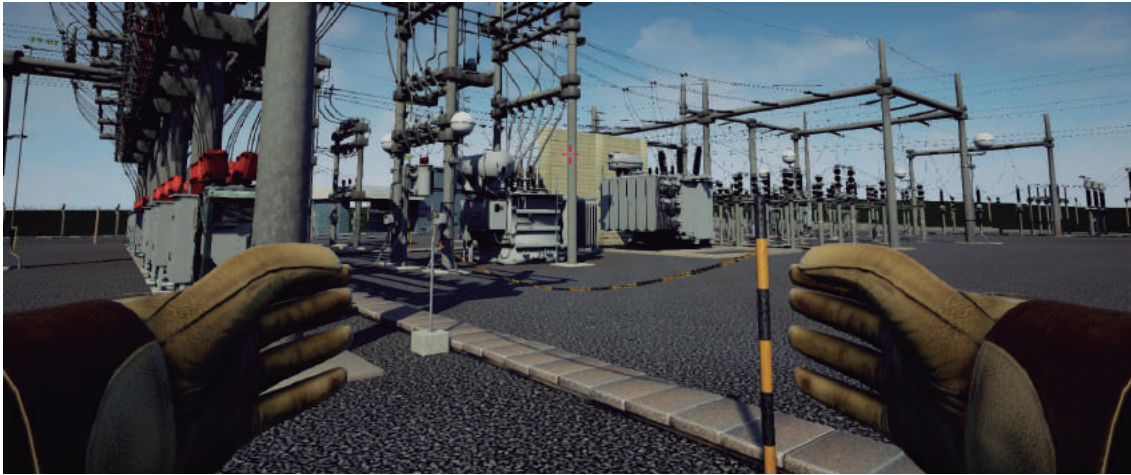
Figura 1. Subestação virtual da plataforma interativa de treinamento baseada na SE Monte D'Este da CPFL. No ambiente, o electricista é capaz de visualizar as instalações e interagir com os objetos e equipamentos presentes no cenário. As atividades podem ocorrer durante o tempo e a quantidade de vezes necessárias para que o electricista se familiarize com a subestação.
