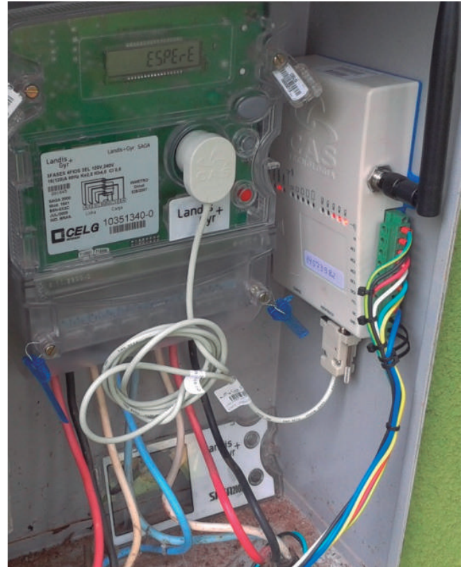
Figura 6: Instalação no condomínio Aldeia do Vale.
