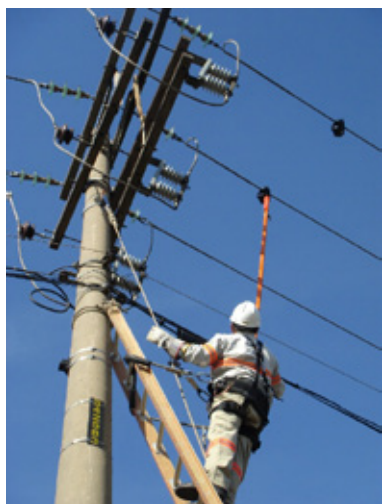
Figura 5 – Instalação do lote pioneiro na rede de distribuição da CPFL. Figura 6 – Instalação
