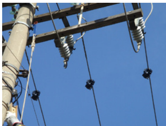
Figura 5 – Instalação do lote pioneiro na rede de distribuição da CPFL.
