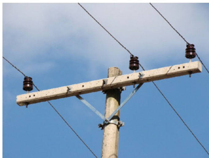
Figura 1 – Cruzeta de concreto leve.
